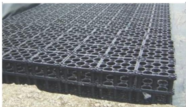
圖2-3.11地下礫石層與組合式蓄水框架的地下貯集滲透工法
