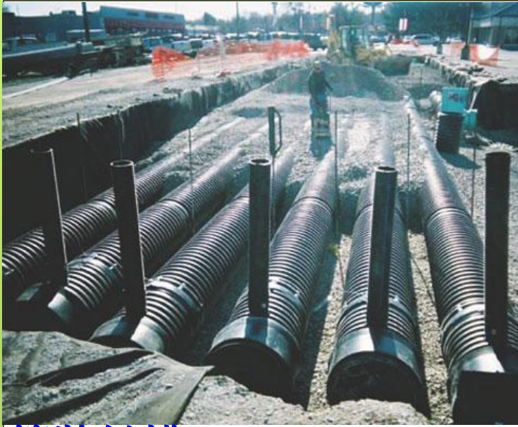
管狀儲槽 (孔隙率50%)
