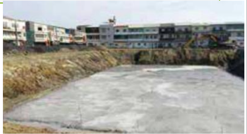
2. 貯留槽基礎打底
