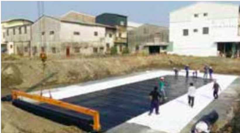
3. 鋪設土工合成材料
