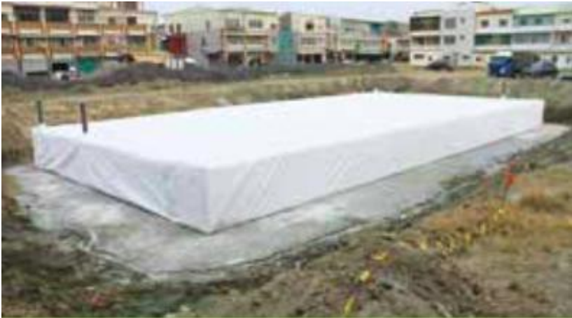
7. 貯留槽包覆保護地工織物
