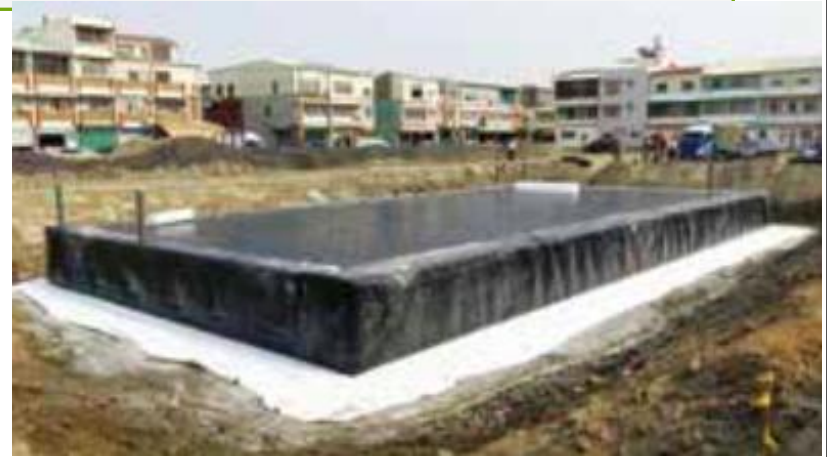
6. 貯留槽包覆地工防水膜
