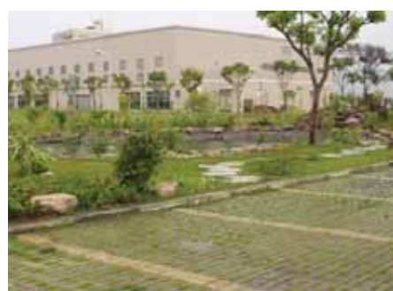
圖 7-13 高性能透水鋪面
