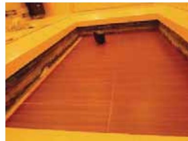
(b) 輕量衝擊源樓板衝擊音測試
