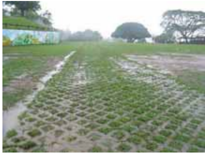
圖 7-5 高性能透水鋪面
