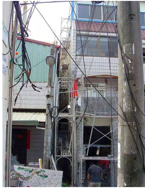
圖3-5.7 住家緊鄰工地，施工鷹架有助攀爬
