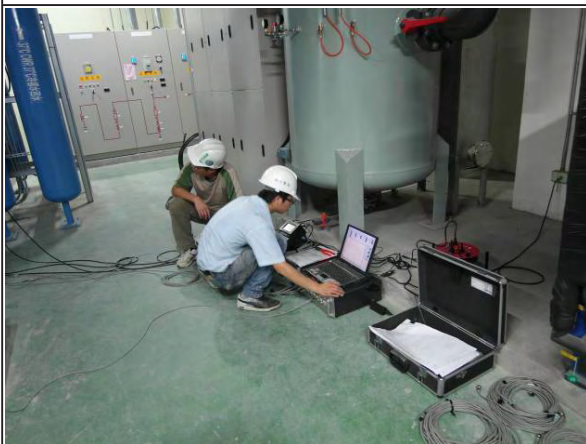
【空調主機測試分析儀架設】
