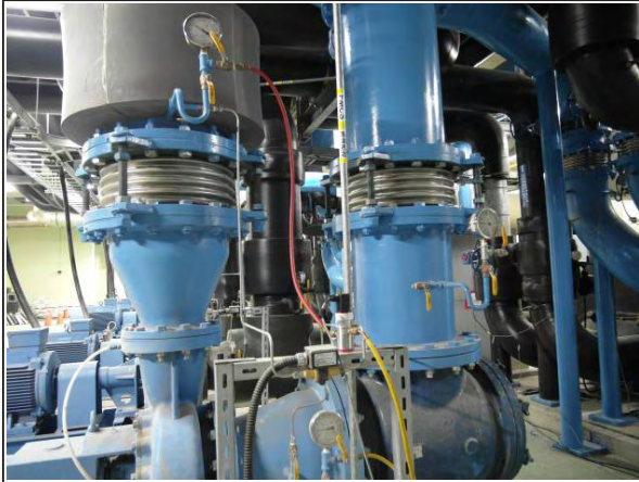
【冷卻水泵壓差計安裝】
