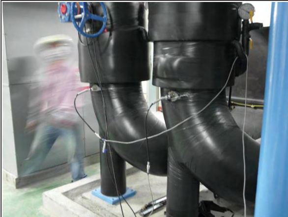
【空調主機冰水出入端溫度計安裝】
