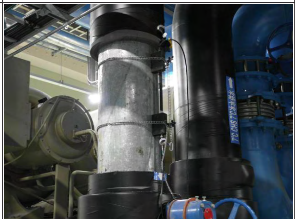
【冰水泵超音波流量計安裝】
