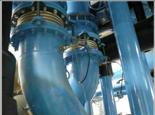
【空調主機冷卻水出入端溫度計安裝】
