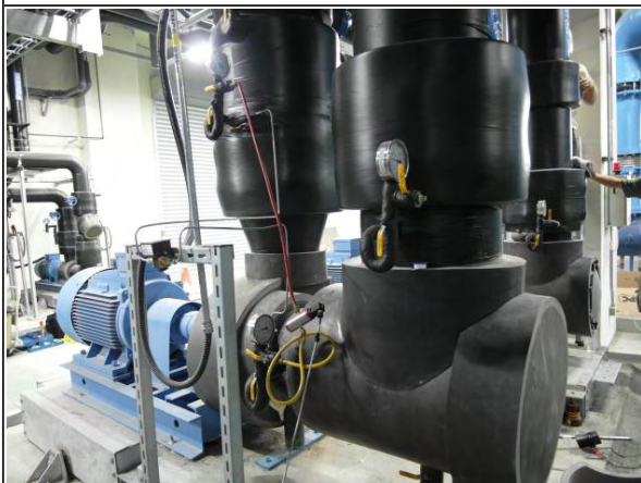
【冰水泵壓差計安裝】
