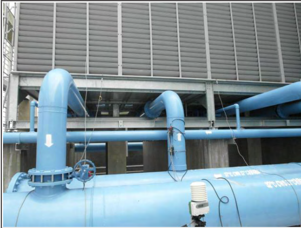
【冷卻水塔超音波流量計管路1安裝】
