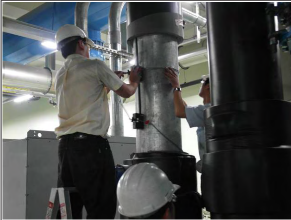
【空調主機冰水管路超音波流量計安裝】
