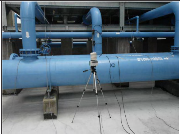
【冷卻水塔外氣溫濕度計安裝】
