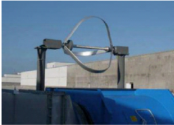
圖2-6.3 氣驅式風力發電系統(一)
