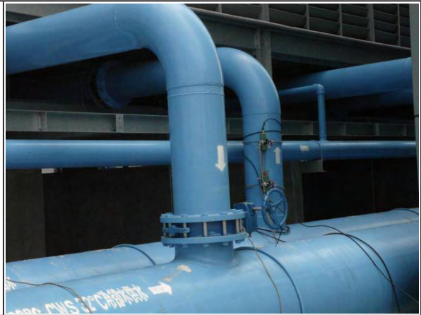
【冷卻水塔超音波流量計管路2安裝】
