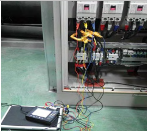
【冷卻水泵電力分析儀安裝】
