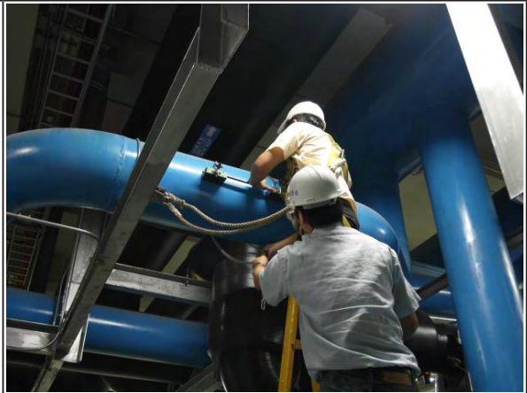
【空調主機冷卻水管路超音波流量計安裝】
